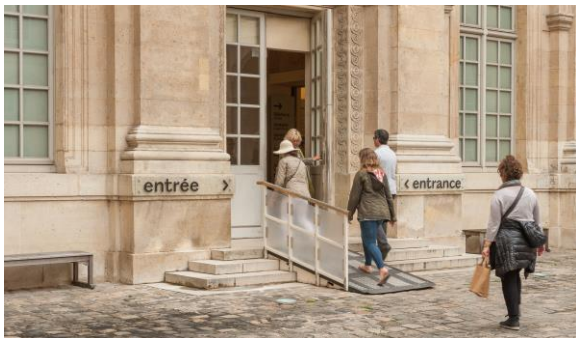
Entrée du musée : le plan incliné et la cour pavée. Photo : Paul Allain © mahJ
